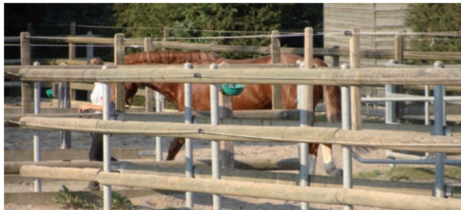
Holzfrassschutz durch Kombination Holz mit Elektrozaun
